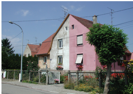
Une maison bi-familiale à deux stades de rénovation et d'extension à Bollwiller.
