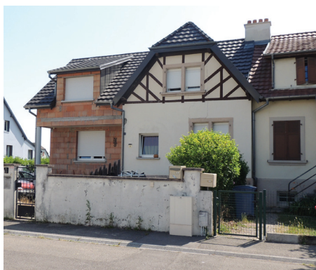
Extension et surélévation inspirée d'à côté, mais dénaturée par son retrait. Un concentré des enjeux de rénovation.
