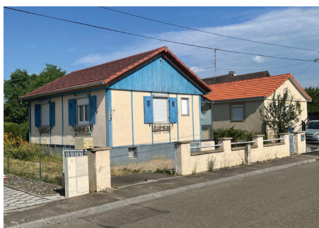
Maison individuelle préfabriquée en bois de la cité Jeune Bois à Wittenheim.
