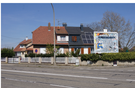
Une certaine cacophonie architecturale semble régner pour la rénovation du patrimoine résidentiel existant.
