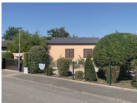
Les chalandonnettes, un habitat individuel dense à l'architecture moderniste, une des architectures de la cité Jeune-Bois.
