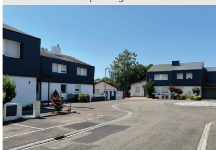
Le quartier de Bretagne à Baldersheim joue des typologies individuelles et collectives et des matériaux «bretons».
