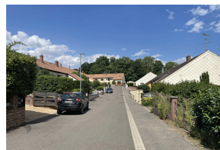
Les formes architecturales en redents animent l'espace public le long de la rue des Castors à Didenheim.
