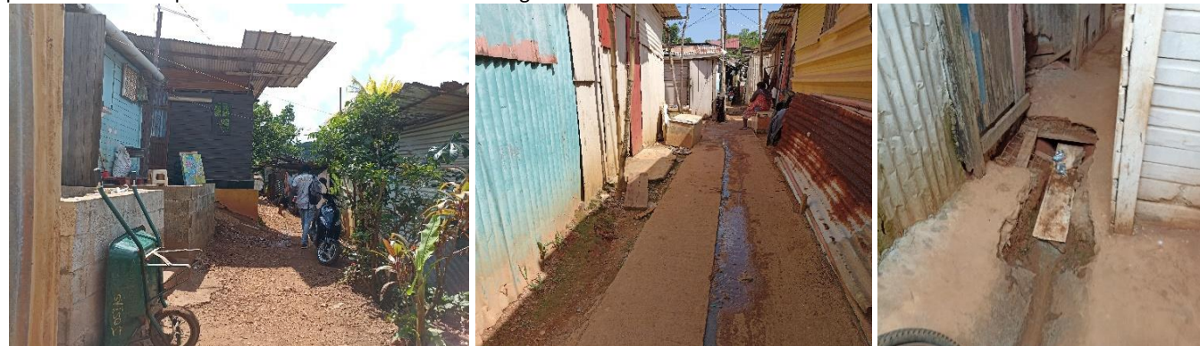
Voie en latérite, plus ou moins entretenue en fonction des endroits
