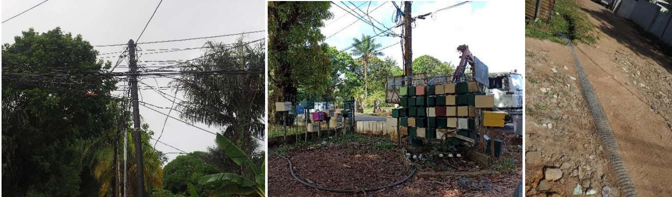
Branchements électriques illégaux. Raccordement partiel à l'eau au niveau de l'entrée du quartier, réseaux d'assainissement partiel
