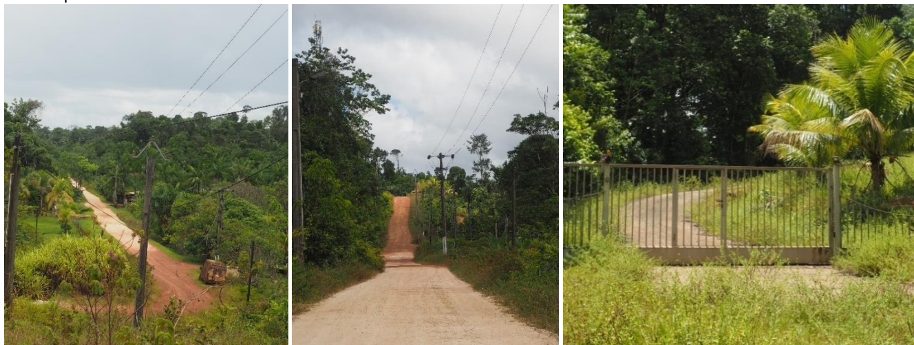
Voiries principales en latérite, plutôt bien entretenues, voirie privée bétonnée
