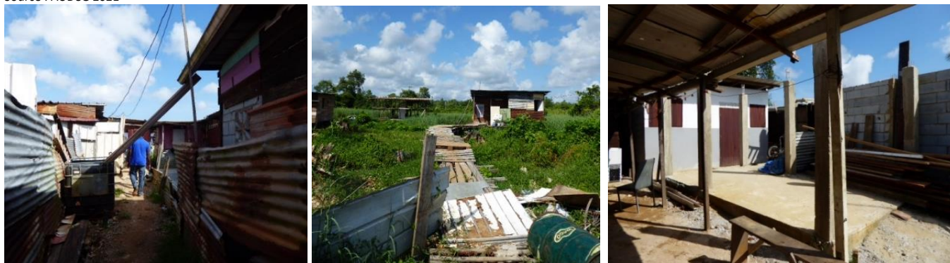
Bâti très dense, majoritairement en tôle ou bois, aspect précaire, quelques constructions en dur
