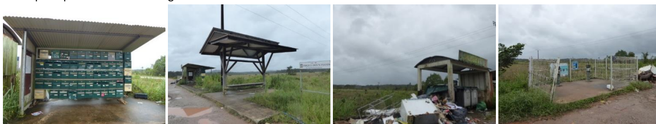
Boîtes aux lettres, arrêt de bus, collecte des déchets et borne fontaine d'eau potable rassemblés en entrée de piste
