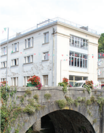
Architecture à inspiration art déco à côté du pont rue Pasteur
