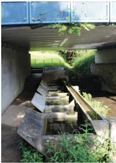
Dispositifs liés à l'eau qui ponctuent l'espace public
