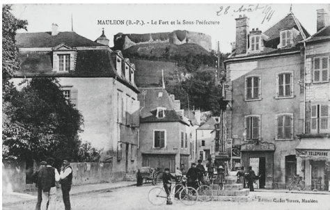
On peut voir sur une photo ancienne comment l'usage de l'espace environnant du pont était principalement piéton et cycliste
