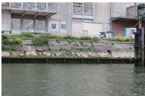
**Palplanches surmontées de dalles béton dégradées sur perré maçonné, à proximité d'activités industrielles, photo M.P-B**
